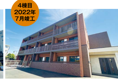
4棟目 2022年7月竣工 コジストペアー南林間
