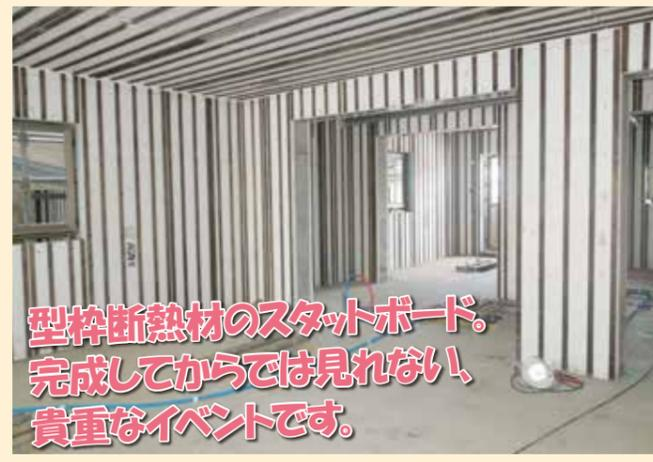
型枠断熱材のスタットボード。
